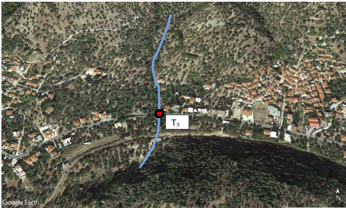
Εικόνα 2.3: Η θέση του τεχνικού γεφυρώσεως T_3 το οποίο βρίσκεται στον δρόμο που συνδέει τους οικισμούς Τρίγωνα και Πλαγιά.
