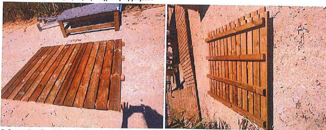
Ενδεικτική εικόνα ξύλινου διαδρόμου εξυπηρέτησης ΑμΕΑ
